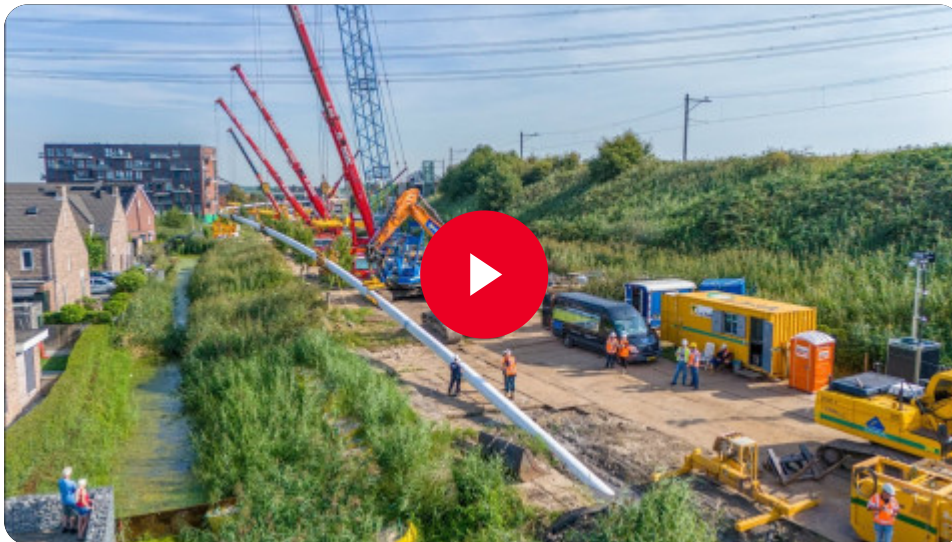
project "Boring onder de Merwede"
